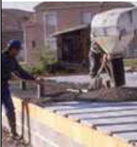
Mise en place du BC Plancher
