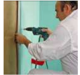
Vissage contre cloison PRÉGYDRO
