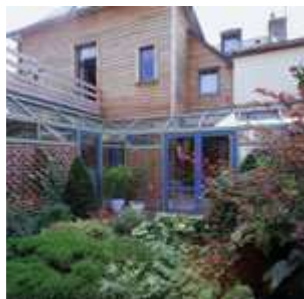
La véranda encastrée, liaison entre deux bâtiments
