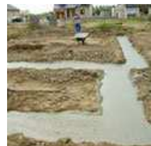
Fondation de Maison Individuelle
