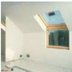
Pièce sous toiture
