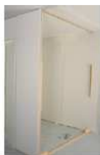
Cloison alvéolaire en cours de montage
