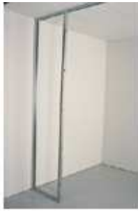
Structure d'une cloison PREGYMETAL
