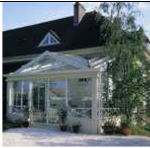
En appui sur un soubassement maçonné, la véranda fait corps avec le bâtiment
