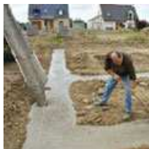
Coulage en BAN Fondation
