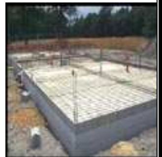
Réalisation d'un plancher sur vide sanitaire
