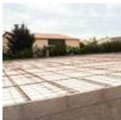
Plancher Hourdis Polystyrène1
