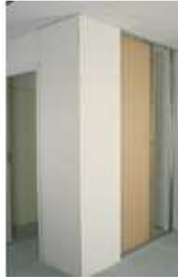
Cloison PREGYMETAL en cours de finition
