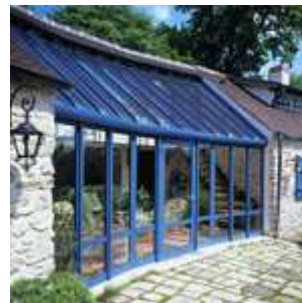
Dans cette version encastrée la véranda assure la liaison entre les deux parties du bâtiment
