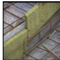
Dalle de Compression en BC Plancher1
