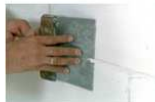
Suppression du surplus de colle
