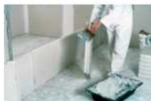
Montage d'une cloison en carreaux colle
