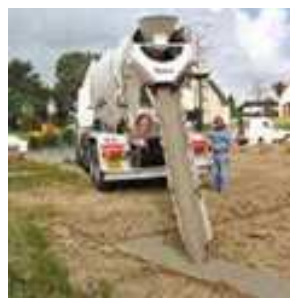
Coulage en BAN Fondation2
