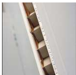
Le réseau de la cloison alvéolaire
