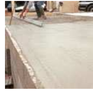
Dalle de Compression en BC Plancher2
