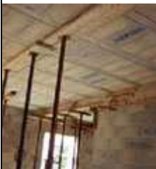
Mise en place du BC Plancher
