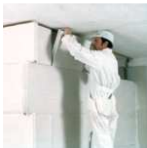
Pose du dernier rang de carreaux
