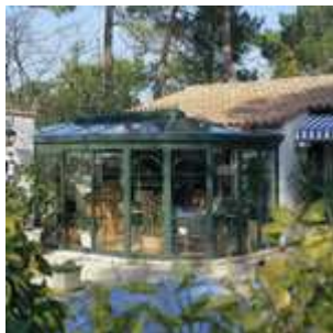
Nichée dans l'angle de la maison cette véranda rayonnante complète l'organisation de plan de façade
