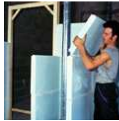
Montage carreaux de Plâtre PF3
