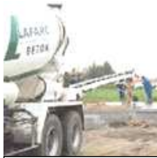
Coulage au Camion-Tapis1
