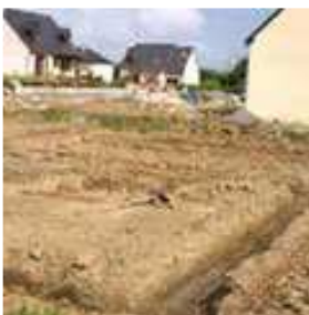
Préparation des fondations
