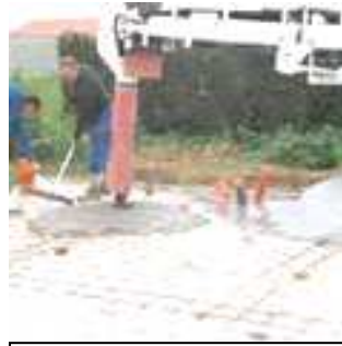
Coulage d'une dalle au camion tapis2
