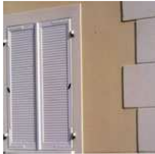
Pierres d'angle, entourage de fenêtre en surépaisseur
